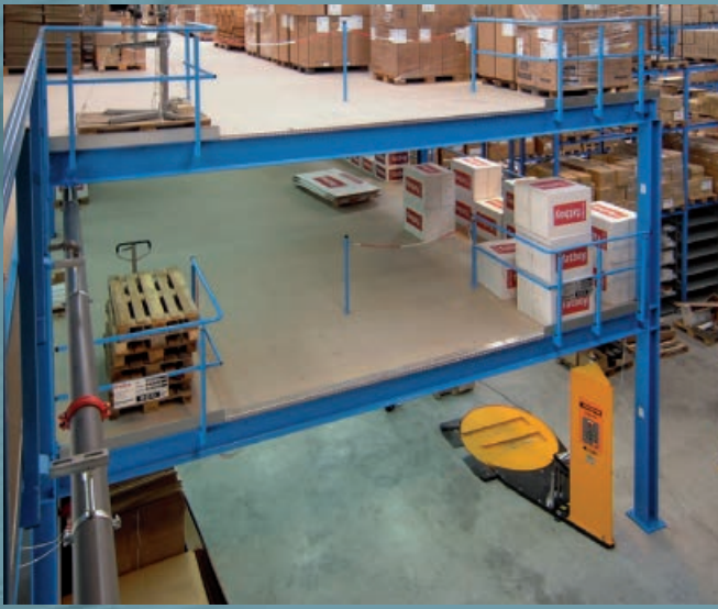
Mezzanine pour entrepôt à plusieurs étages chez un grossiste spécialisé. Stockage de plus de 5000 articles, fabrication et préparation de commandes sur une surface réduite.
