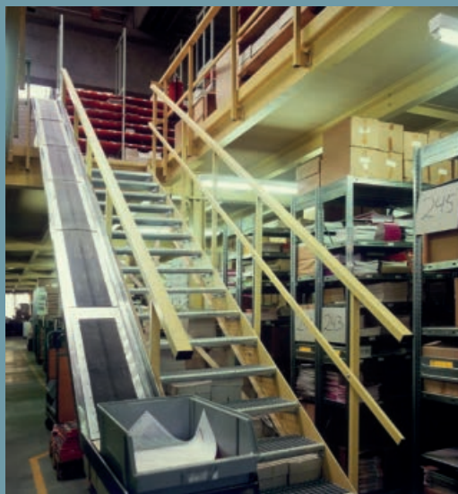
Mezzanine robuste pour entrepôt avec escalier extérieur et système de manutention pour cartons. Les portées élevées permettent une grande liberté de mouvement sous la mezzanine.
