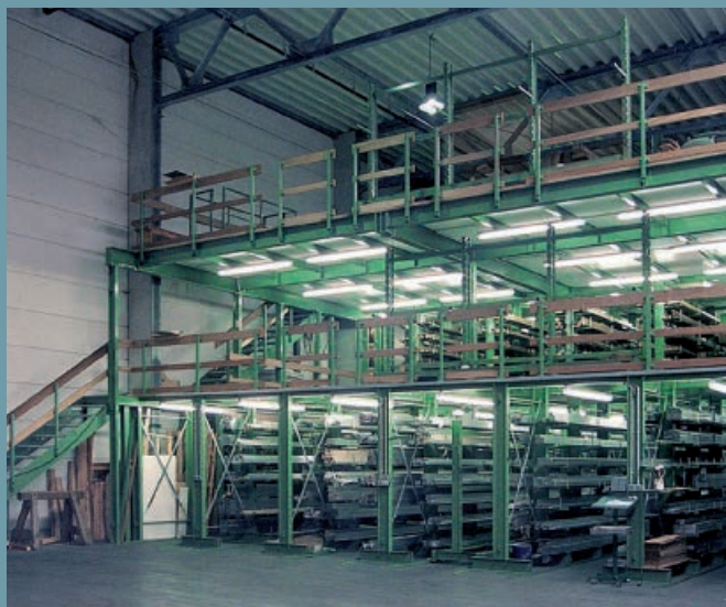
Mezzanine pour entrepôt avec rayonnages à bras portants - Mezzanine pour entrepôt de stockage de métaux. Stockage sur 2 étages de profilés sur des rayonnages à bras portants. Étage supérieur réservé au stockage de marchandises en paquets ou en blocs.
