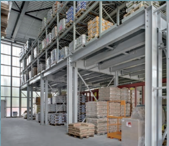
Mezzanine robuste à structure acier dans un entrepôt de matériaux de construction. Ici avec une technique de manutention intégrée grâce à l'incorporation de convoyeurs à rouleaux.
