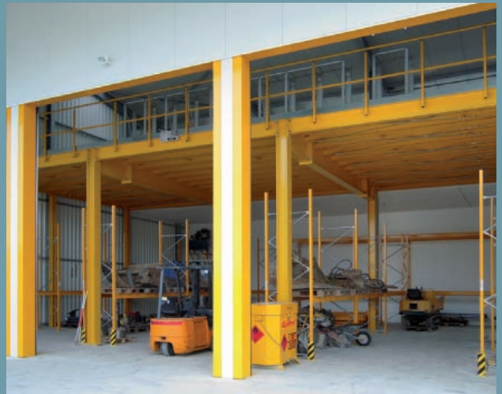
Construction ajustée aux dimensions existantes de l'entrepôt. Mezzanine pour entrepôt avec de grands systèmes d'étagères en-dessous et sur la mezzanine.
